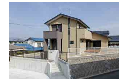
U 邸新築工事
