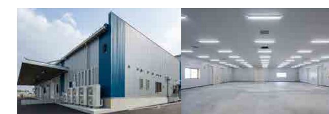
翔葉物流センター倉庫新築工事
