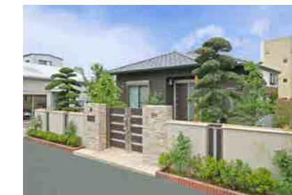
Y 邸新築工事
