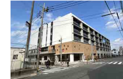
春住小学校新築工事
