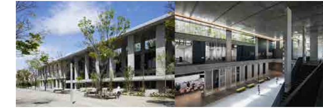
香椎副都心公共施設新築工事
